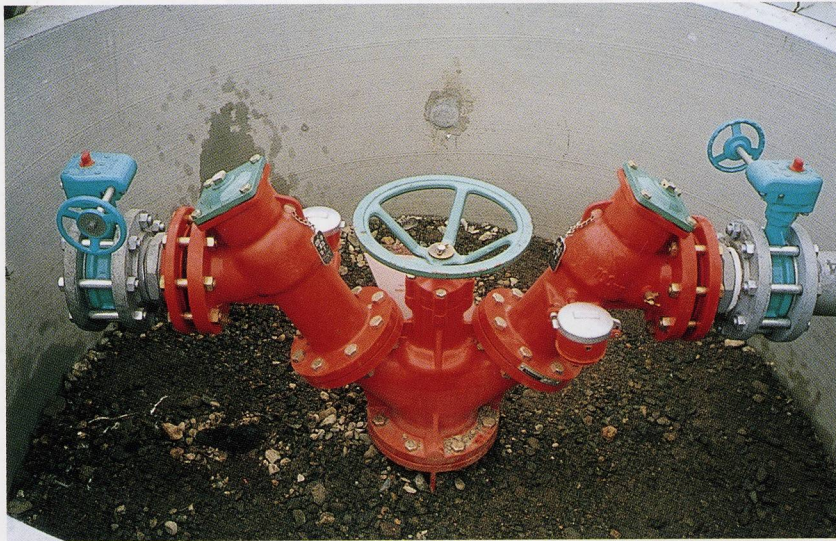
B20型-60-100A DN100S 2口 設置例
